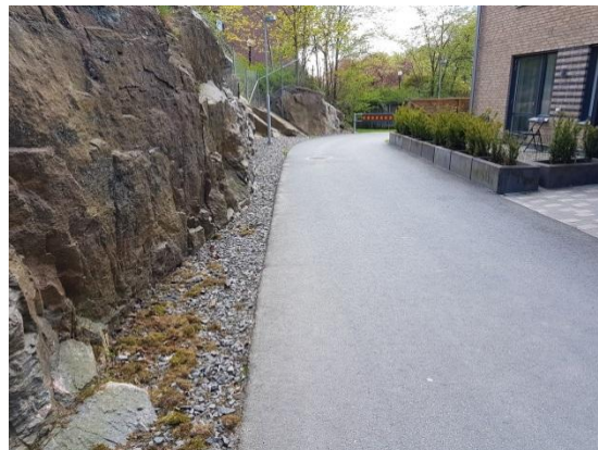
Figur 24. Exempel avskärande åtgärd i form av grussträng invid bergsslänten. Fotot taget vid befintliga flerbostadshus strax utanför planområdet.
