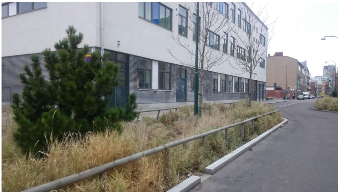
Figur 3. En regnträdgård i Malmö. Dit leds dagvatten från vägen. Foto: Ramböll
