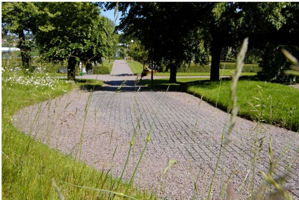
Figur 11. Förstärkt grusgång med pelleplatta. Källa: www.vegtech.se .
