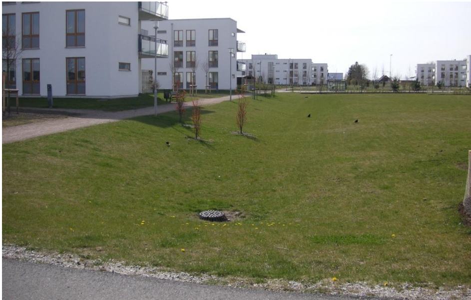
Figur 7. Översilningsyta i Malmö. Foto: Ramböll
