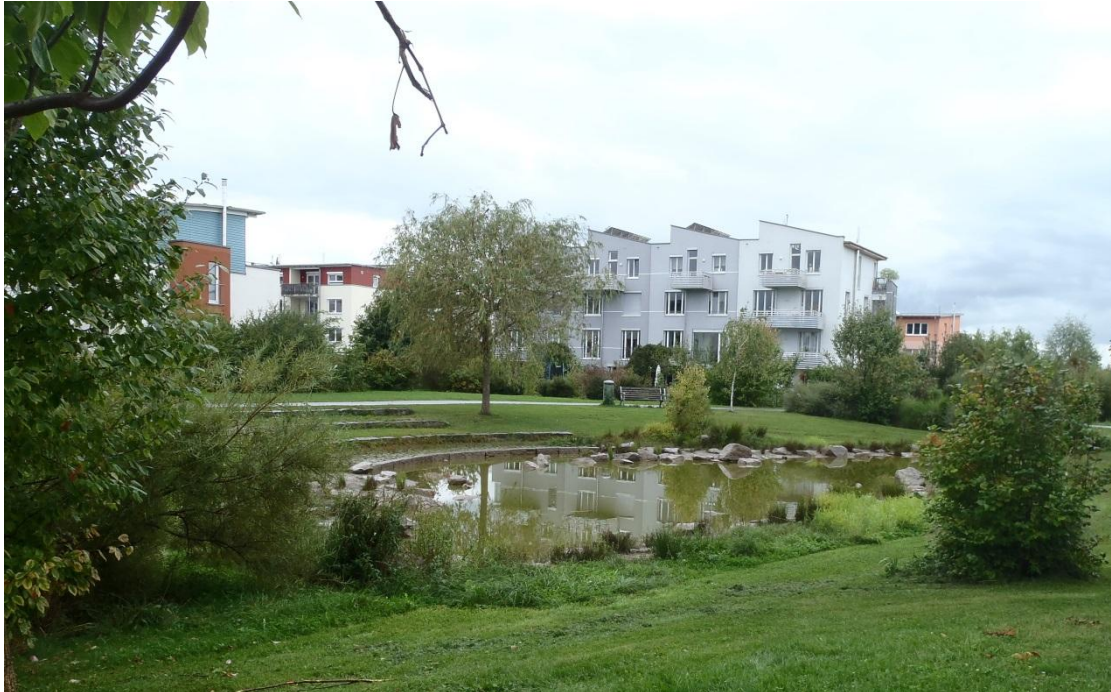
Figur 4. Öppet fördröjningsmagasin i form av en dagvattendamm med permanent vattenyta i ett bostadsområde i Tyskland. Foto: Ramböll
