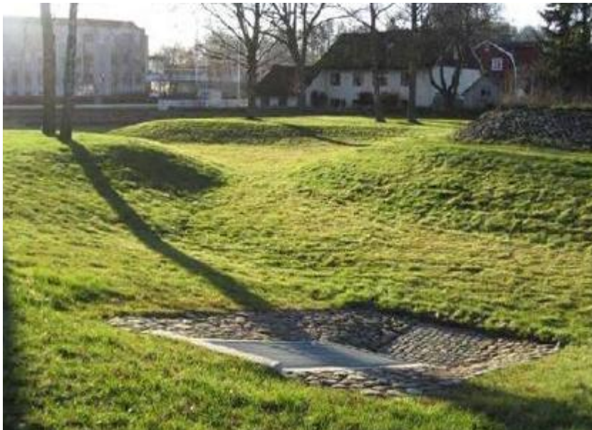
Figur 6. Exempel på utformning av en torr fördröjningsdamm. Källa: Härryda kommuns dagvattenstrategi, 2011.
