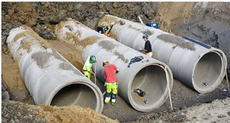
Figur 15. Dagvattenmagasin av betongrör Källa: www.steriks.se .
