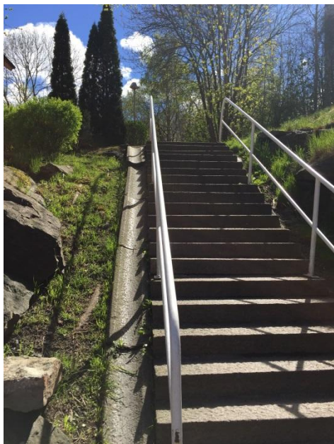
Figur 23. Exempel avskärande åtgärd i form av en öppen ränna, placerad ovan Hebegatan strax utanför planområdet.
