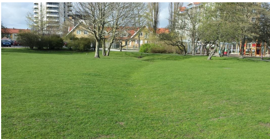
Figur 20. Exempel på svackdike i Malmö. Foto: Ramböll
