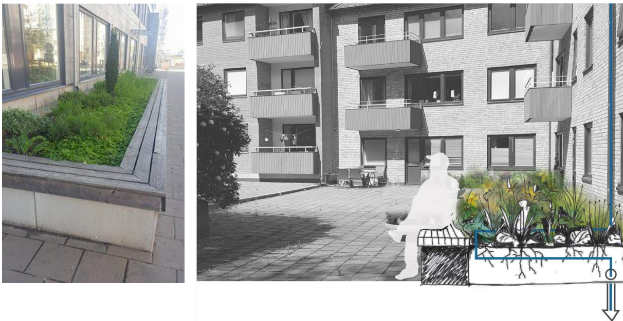
Figur 15. Till höger visas en principskiss av upphöjd växtbädd på innergården framtagen av Ramböll. Till vänster ett verkligt exempel på en upphöjd växtbädd belägen på Hisingen, Göteborg. Foto: Ramböll.
