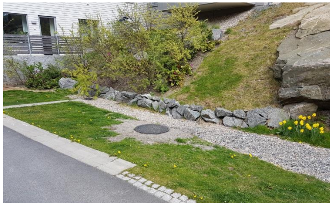
Figur 24. Exempel avskärande åtgärd i form av grussträng invid bergsslänten. Fotot taget vid befintliga flerbostadshus strax utanför planområdet.
